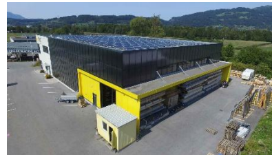
Industriegebäude (Rechenzentren, Produktion etc.)
